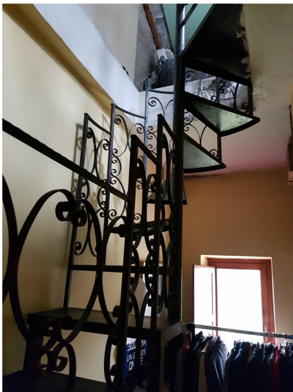
Foto 16 – scala in ferro a chiocciola accesso al sottotetto
