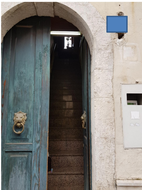
Foto 2 Portone d'ingresso – vista scalinata
